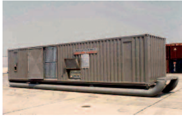
Автономная нагревательная установка мощностью 170 кВт встроенная в обогреваемый контейнер на санях.
